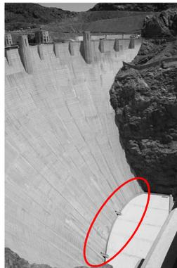
Im untersten Bereich (hier rot markiert) würde das Wasser durch ein Loch am weitesten aus dem Staudamm strömen, da dort die der Abstand zum Wasserspiegel am größten ist. Diese Tatsache zeigen die Beobachtungen aus dem Versuch „Der Flaschenstaudamm“.
